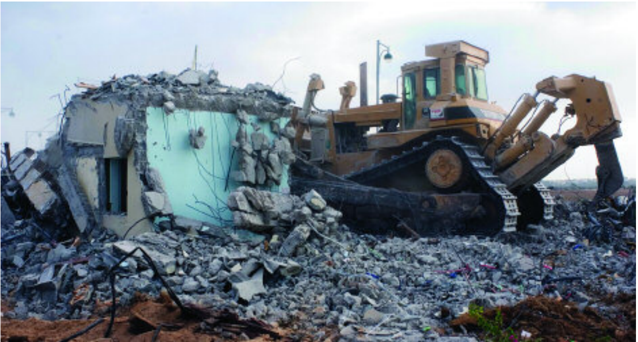
En febrero de 2015, por ejemplo, la Corte Suprema del Estado de Israel decretó tirar abajo nueve viviendas habitadas ya desde hace algunos años, en el asentamiento Ofra en Samaria.
