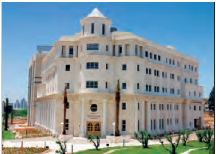
Nuevo edificio de la Universidad Bar-Ilan.
